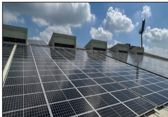
圖 7 長庚大學活動中心太陽能設置容量 584kW
