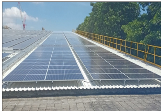
圖 6 台化新港紡紗廠太陽能設置容量 3,052kW
